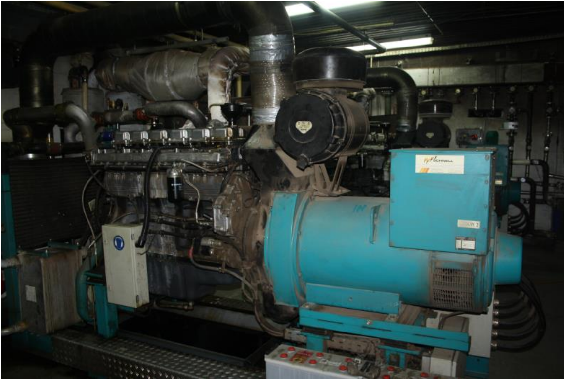
Silnik napędzający generator prądu
