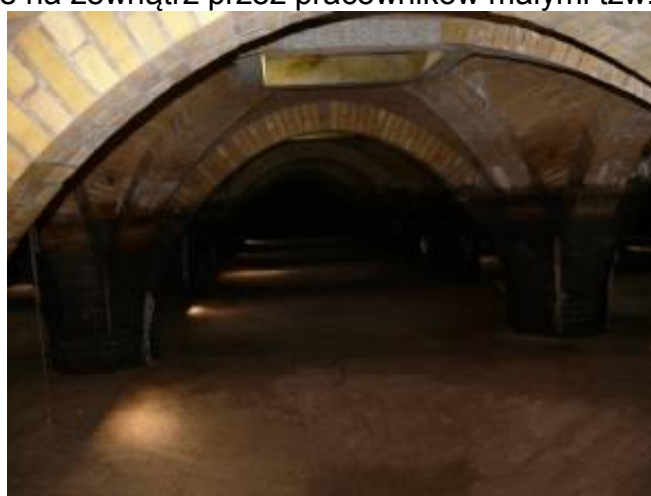
Rys. 29. Zabytkowa już stacja uzdatniania wody
